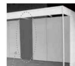
SY-14 壁面カラー工事
